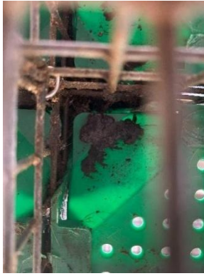
Figure 4 : Vue de dessous d'une mangeoire après nettoyage de routine lors d'un contrôle visuel (non conforme)
